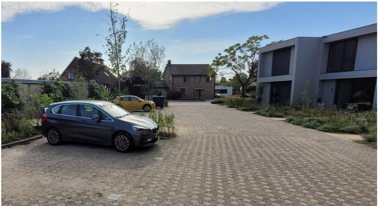
Parkeren op waterdoorlatende verharding in Silvolde
