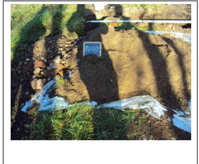
Foto 4. Opgegraven en gezeefd materiaal sleuf RE1-02
