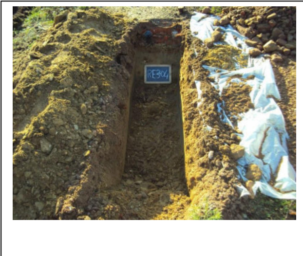
Foto 25. Asbestinspectiesleuf RE3-04
