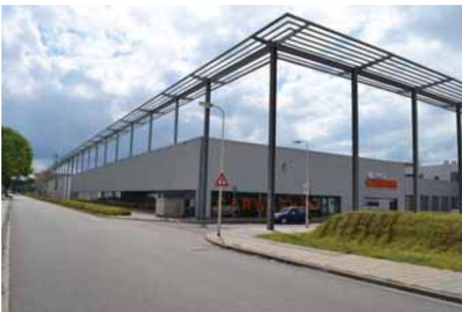
Figuur 12 Referentie wandvorming creëren door middel van schijngewel als onderdeel van de architectuur
