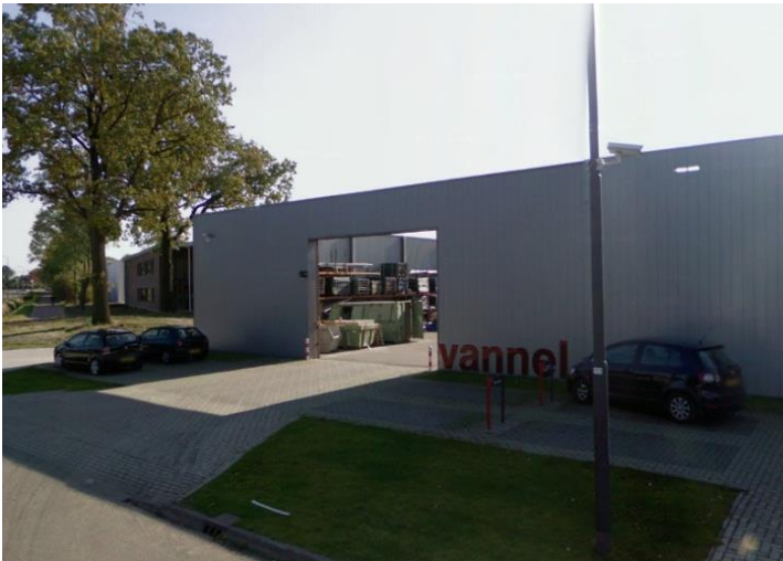
Figuur 8 Wandvorming en opslag uit het zicht.
