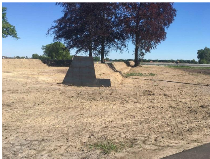
Figuur 25 doorsnijding/beëindiging grondwal door middel van cortenstaal
