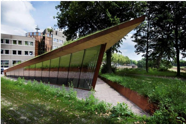
Figuur 14 Referentiebeeld gebouw doorsnijding grondwal
