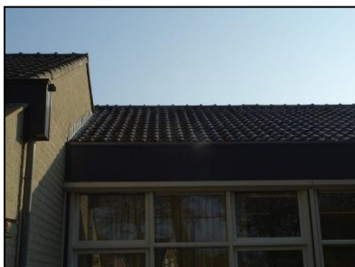
Figuur 6. Gevel met kantpannen.
